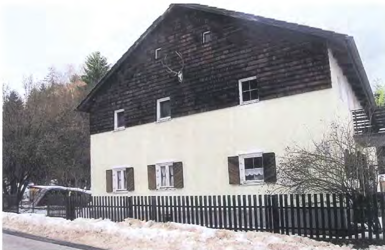
Viele der gemeldeten Jurahäuser sind in einem sehr guten Zustand. Hilfe soll es aber auch geben, wenn Häuser vor dem Verfall stehen.
