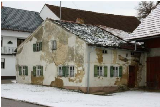
Jurahaushaus zum Teil mit Kalkplattendach, 1733, Wittesheim
